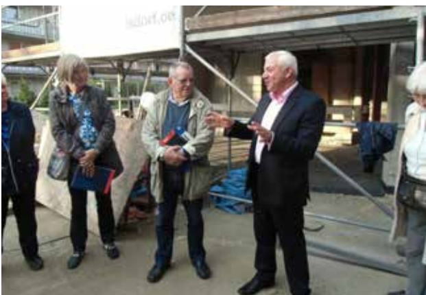
Daniel Abdin empfängt uns auf der Baustelle der neuen „Al Nour Moschee“, der ehemaligen Kapernaum Kirche, im Herbst 2016.
